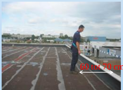
Houdt ruim voor de dakrand halt en wijk niet meer dan 30 graden af van de haakse lijn
